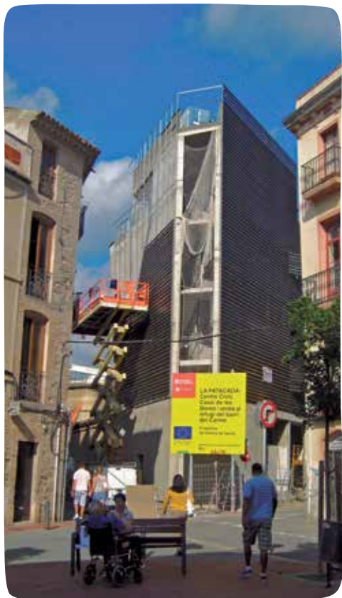
Construcció del nou edifici per al Centre cívic i Centre de les dones, al costat dels antics safareigs públics. Barri del Carme, Reus, 2010.
